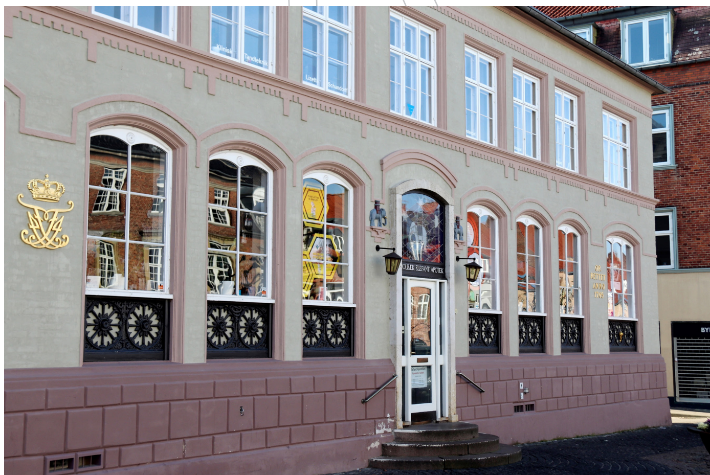
Den historiske bykerne i Holbæk. Øverst Museet, nederst Det Gamle Elefantapotek i Ahlgade. Bygninger sætter deres markante præg på bybilledet og erindrer en om historien og fortællingen om den gamle købstadsby.
